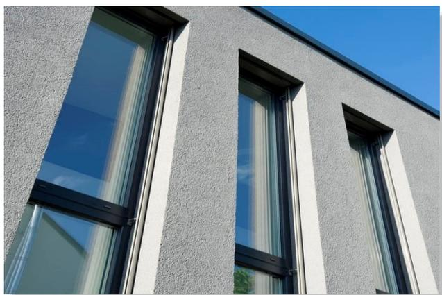
Le châssis de fenêtre et de la porte-fenêtre est en PVC, type SCHÜCO ou REHAU ou similaire (valeur Uf définie suivant le calcul énergétique). Ils sont équipés d'un triple vitrage isolant (valeur Ug définie suivant le calcul énergétique).
